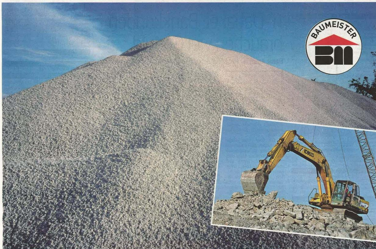
Durch selektiven Rückbau und Annahmekontrolle der Materialien in den Aufbereitungsanlagen wird aus Baurestmassen, die ein hochwertiger Baustoff im Bauteil waren, ein Qualitätsbaustoff
