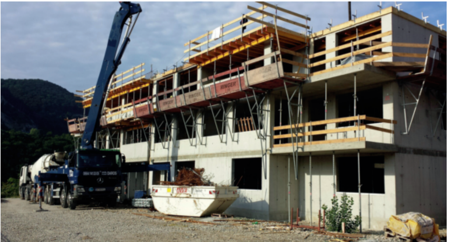
Wohnbau Waldmühle Rodaun – Vorbildwirkung in puncto umweltfreundliche Baustelle, das gesamte Abbruchmaterial wird vor Ort verwertet, sortenrein geordnet und nur die Sondermüllstoffe werden per Lkw abtransportiert
