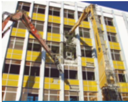
Abbruch des Postgebäudes am Wiener Südbahnhof
